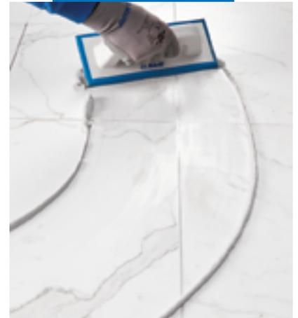
*Aplicación de Ultracolor Plus en pavimento con lana de goma sobre baldosas de gres porcelánico efecto mármol*
